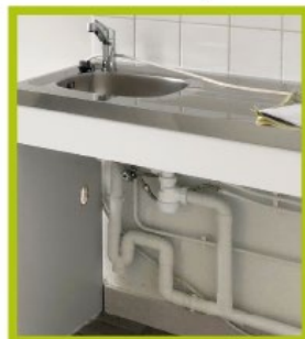
Mitigeurs spécifiques, siphons déportés pour les points d'eau
