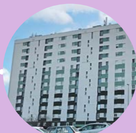
BELLEVUE | LIMOGES 107 logements réhabilités Livraison : février 2026
