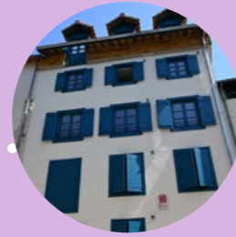
PONT ST-ÉTIENNE | LIMOGES 8 logements réhabilités Réception : juin 2025
