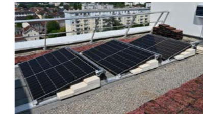
Installation panneaux solaires sur le toit terrasse de la résidence Montjovis
